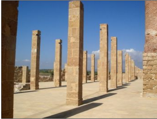
I pilastri del capannone della tonnara.
